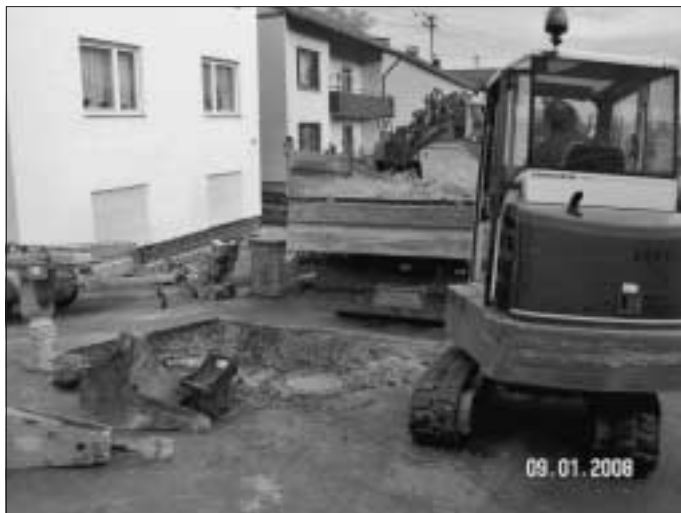
Reparaturarbeiten in der Neuffenstraße
